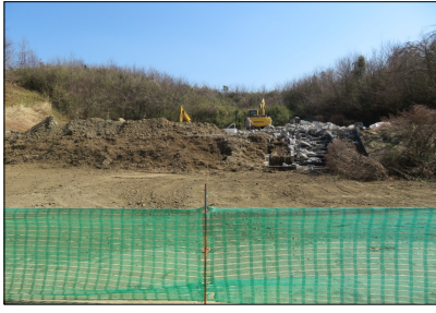
プール解体中、現状
