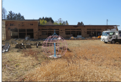
保育所解体中、現状
